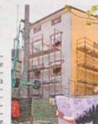
Il cantiere a Porto
